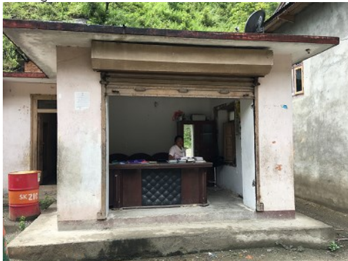
D1. ढुङ्गा खानीको प्रशासनिक भवन
